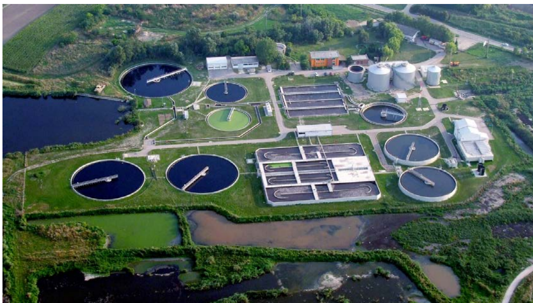
Postrojenje za tretman otpadnih voda preduzeća JKP Vodovod i kanalizacija Subotica
