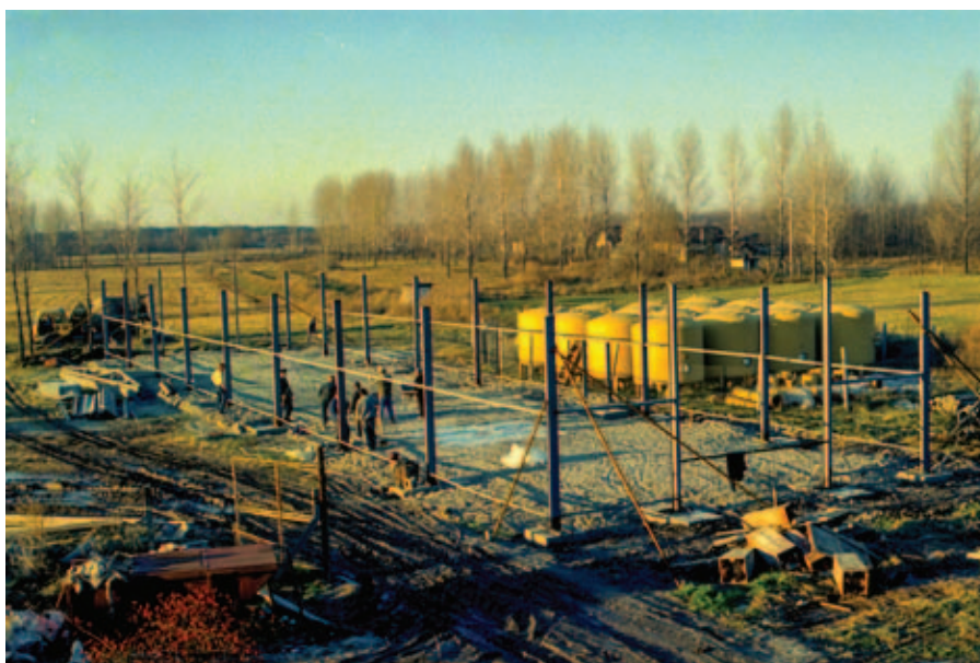
Početak izgradnje fabrike vode 1989. godine
