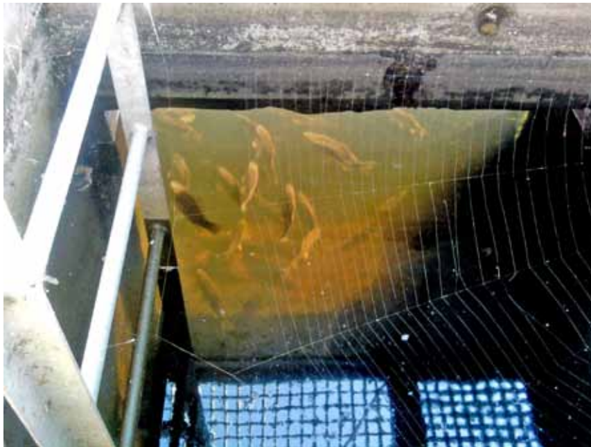
Izlazna prečišćena voda - novo stanište riba !
