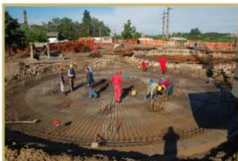
Tretman mulja – anaerobni digestori
