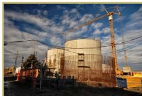
Tretman mulja – anaerobni digestori
